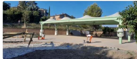
Câblage du réseau électrique (spots encastrés)
