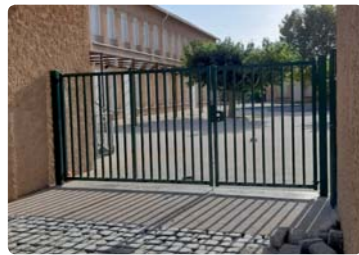
17 août: pose d'un portail flambant neuf pour l'entrée principale
