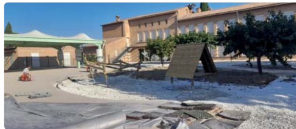
19 août: Mise en place des premiers jeux
