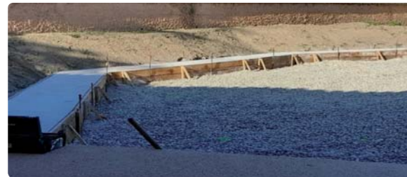
21 août: dalle de béton fermant le plan incliné destiné aux gradins
