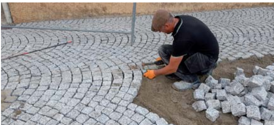
Pose manuelle des pavés de granite
