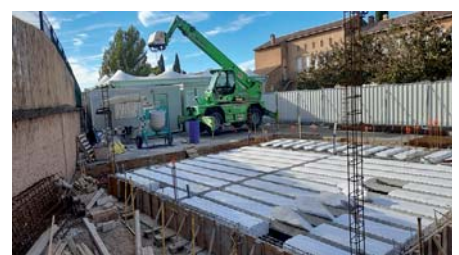
Fondations du local sanitaire
