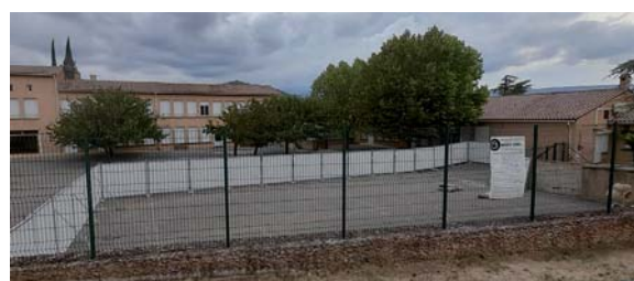
Le chantier comporte une palissade qui réduit une partie de la cour jusqu'au printemps
