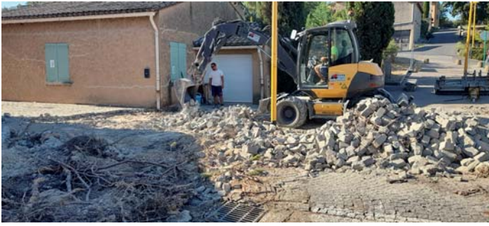
Chantier de démolition
