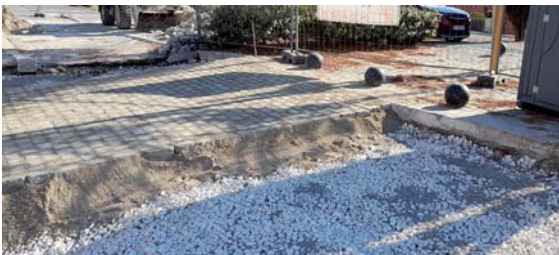
Sous les pavés, un lit drainant fait de pierres et de sable
