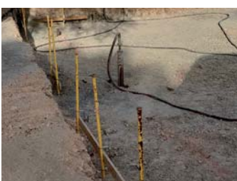
Pose de micro-pieux pour l'assise du futur local sanitaire
