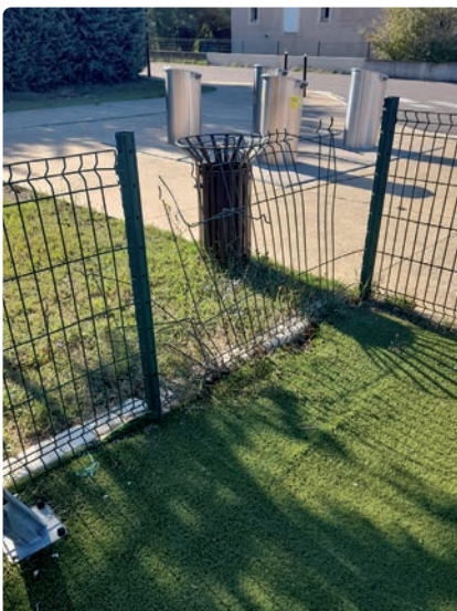
Clôture aire de jeux
