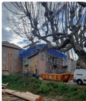
Place de la mairie Réhabilitation d'un bâtiment communal: réfection totale de la toiture (1 ère tranche)
