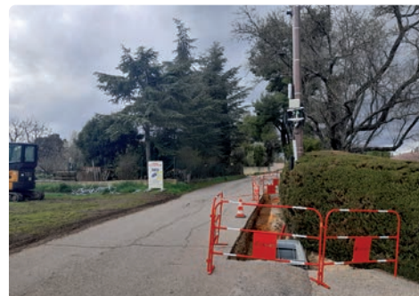
Tartuguière Enfouissement des lignes électriques et du réseau Télécom par le Syndicat d'Énergie Vauclusien (2 e tranche)
