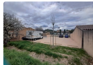
Cerisaie Parking équipé d'un lampadaire solaire; 8 places dont 1 PMR (Personne à Mobilité Réduite)
