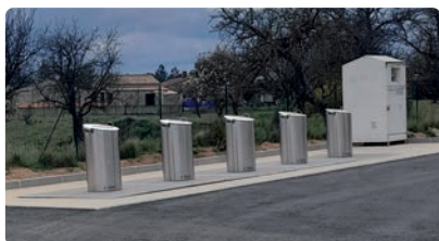
Chêne/Perrotet Pose de 5 conteneurs enterrés
