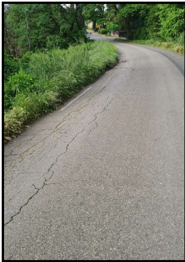
Photo des importantes déformations sur la rive gauche de la chaussée
